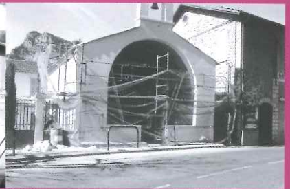
puis OUVERTURE DE LA FAÇADE
